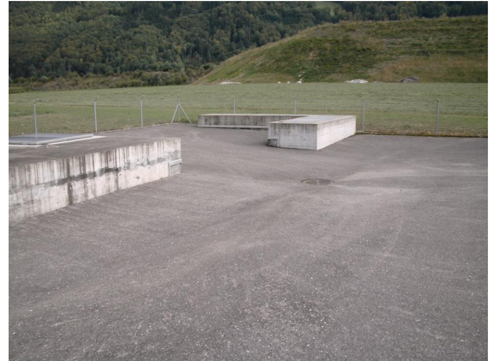
Zone de protection S1 clôturée et protégée
